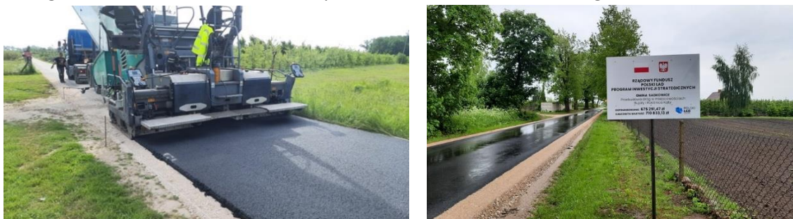
Fot. Przebudowa dróg w miejscowościach Bujały i Rokitnica-Kąty.
