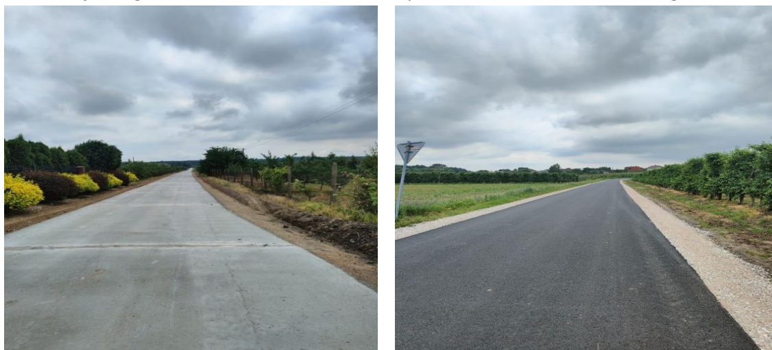
Fot. Przebudowa drogi w miejscowości Kłopczyń
