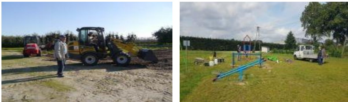
Fot. Budowa placu zabaw dla dzieci w Jajkowicach
