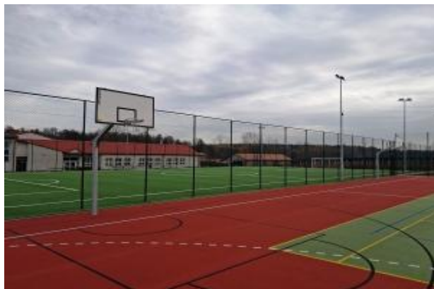
Fot. Boisko wielofunkcyjne przy S. P. w Lubani
