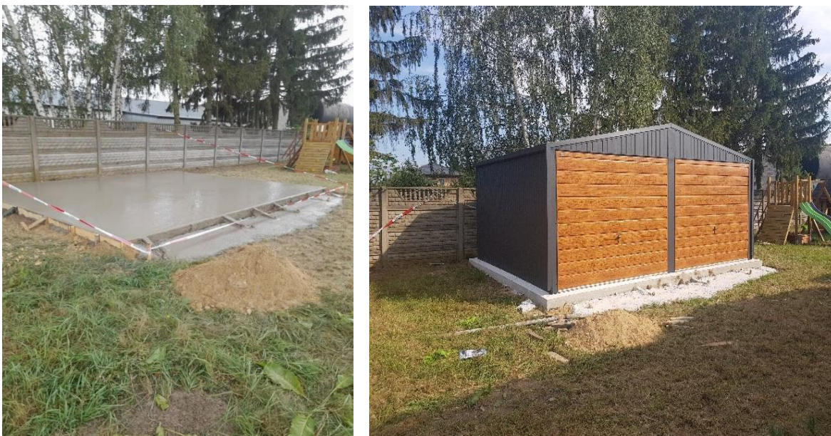
Fot. Budowa garażu blaszanego w Żelaznej
